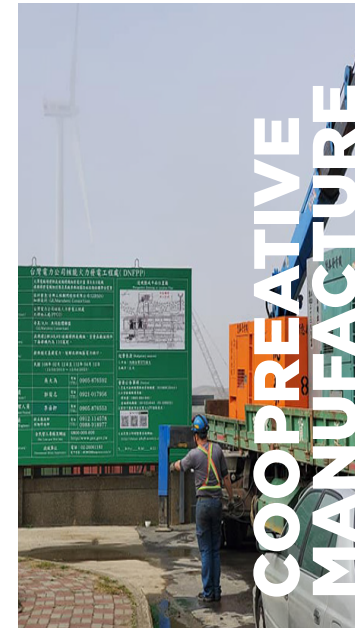
大潭電廠新建工程 2020通風機發電機協助工程
