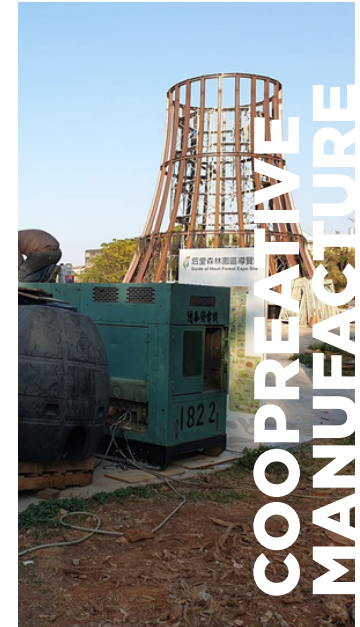
台中燈會主燈施作 2020台中燈會主燈發電機供電
