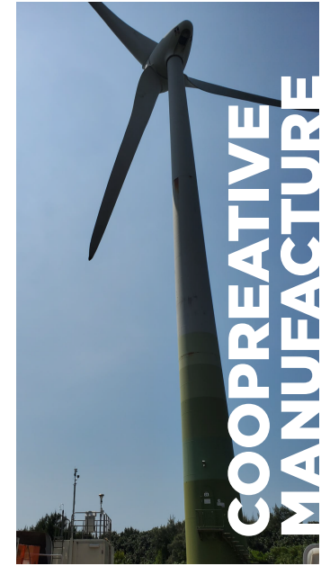
桃園生質能中心風力發電 2021桃園生質能中心發電機公共工程
