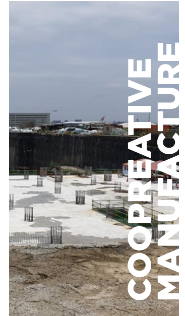
桃園三期航廈新建工程 2019中華航廈發電機公共工程
